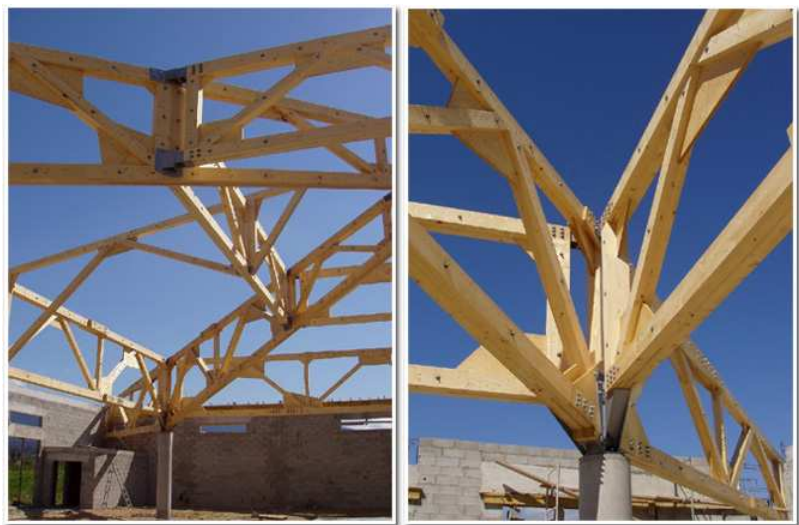
Pose des éléments préfabriqués, assemblés par le système Ariane
