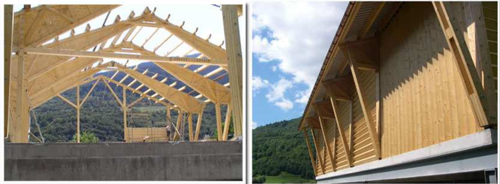
Montage de la poutre à trois articulations et vue de la façade latérale Wenus avec jambes de force
