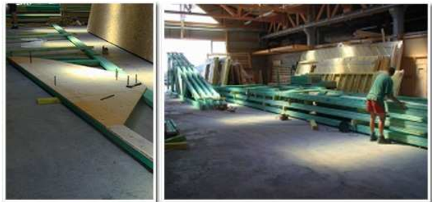
Taille des pièces et préfabrication des demi-fermes en atelier
