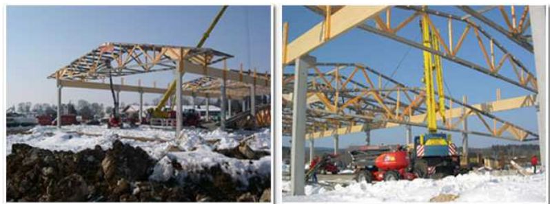
Assemblage des demi-fermes et montage sur chantier
