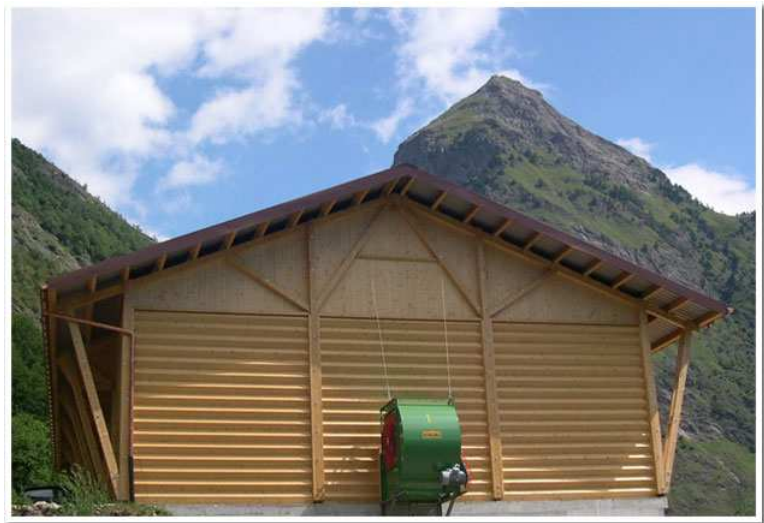
Vue de la façade Wenus avec section de la ferme apparente et jambes de forces
