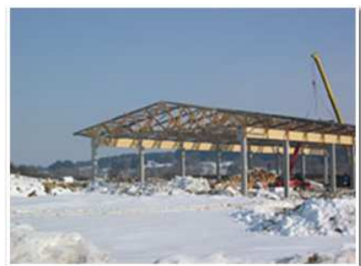
Vue générale de la charpente sur poteaux béton et poutre lamellée-collée
