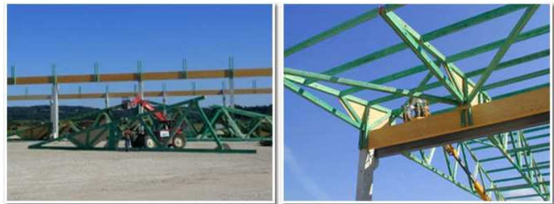
Assemblage des demi-fermes et montage sur chantier
