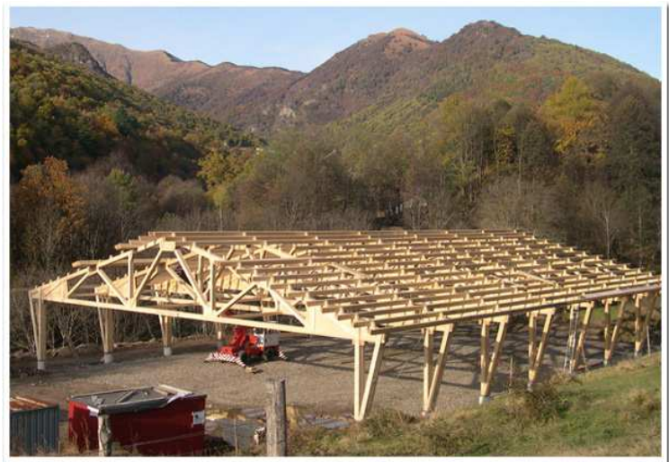
Vue générale de la structure du bâtiment
