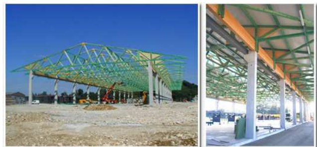
Vue générale de la charpente sur poteaux béton et poutre lamellée-collée
